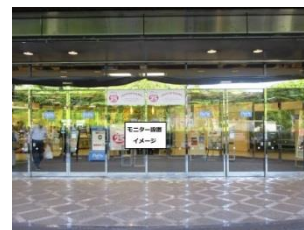
西武入間ペペ 1F 正面入口（ロータリー）
